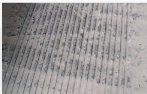
Rillenprofil in einer Betonfläche
