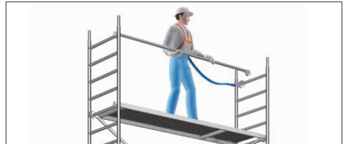
Bild 3: Sichere Montage der Rückenlehnen mit PSA
