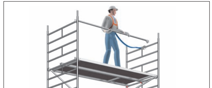
Bild 3: Sichere Montage der Rückenlehnen mit PSA
