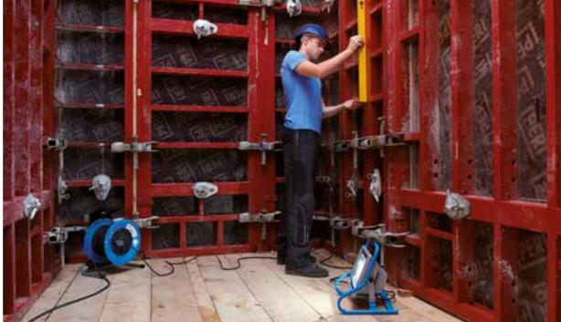
Zur hellen Ausleuchtung von großen Räumen und Freigeländen dient der Halogenstrahler. Er ist erhältlich in verschiedenen Ausführungen auf dem Stativ, im Tragegestell und zur Wandmontage.
