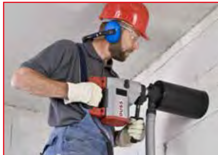
Trockenbohren in Mauerwerk mit Staubabsaugung, handgeführt
