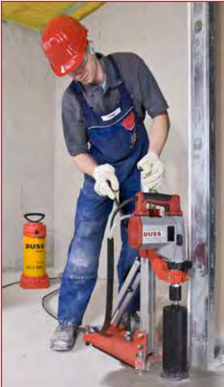
Nassbohren in Beton, ständergeführt
