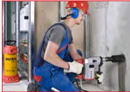
Dosensenken in Beton – nass, handgeführt
