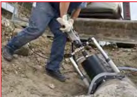
Anbohren von Betonrohr – nass, stativgeführt
