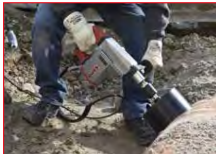
Anbohren von Kunststoffrohr – trocken, handgeführt
