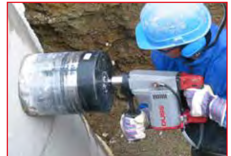
Anbohren von Betonschacht – nass, handgeführt
